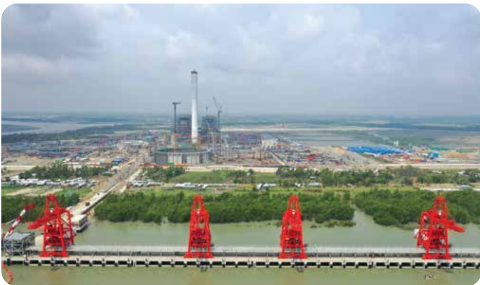
Coal Jetty : Payra 1320 MW TPP Project
